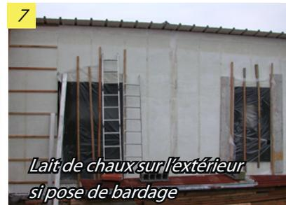
Reste à poser le bardage ou un enduit chaux et sable en 2 ou 3 couches.
