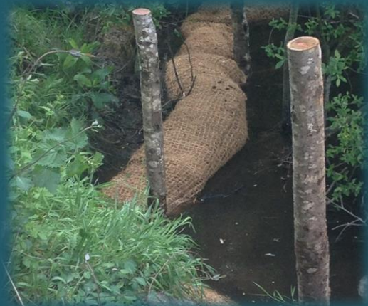
Dans le cadre d'une démarche durable, nous préconisons l'utilisation de pieux en bois non traités. Le châtaigner convient parfaitement à cet usage.
