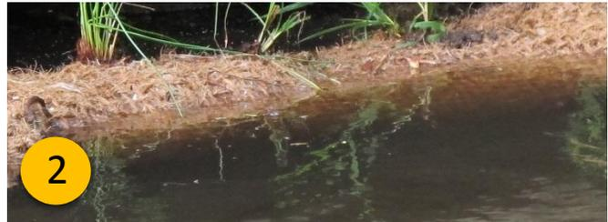
Pour permettre une bonne prolifération de la flore, la fascine doit être partiellement immergée : au moins 1/3 de sa hauteur.
