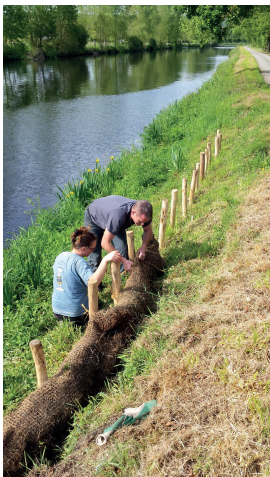
Pose des piquets en châtaigner pour accueillir le Chanvriberg®.
