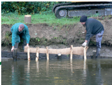
Il suffit d'appliquer la fascine contre les piquets.
