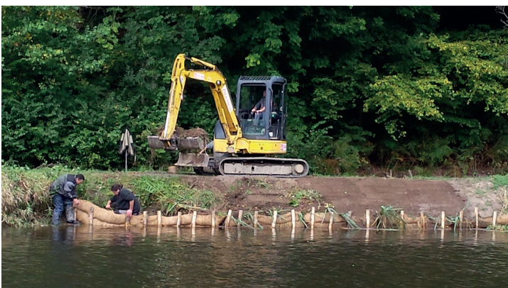
Vue d'ensemble du chantier. Après quelques mois l'enracinement naturel des plantes sera effectif et la berge renforcée.
