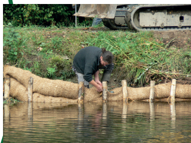
Les Chanvriberg® sont reliés entre eux et sur les piquets bois.
